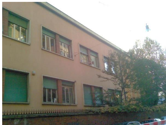
Figura 1.1 - Vista della facciata esposta a Nord
