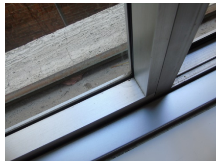
Figura 8.1 - Particolare serramenti da sostituire e delle attuali valvole dei radiatori, prive di testina termostatica
