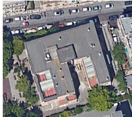
Figura 8.3 - Foto aerea della copertura piana su cui intervenire
